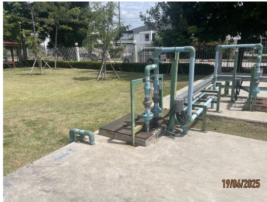
รูปที่ 13 ระบบบำบัดน้ำเสียของโครงการ
